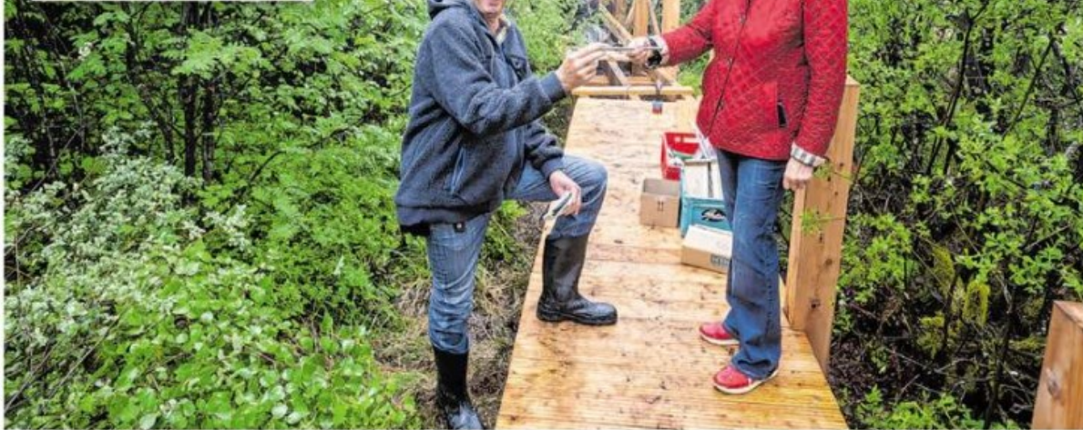
Die Arbeiten am neuen Steg am Palsen im Venn bei Mützenich schreiten voran: Udo Thorwesten von der Unteren Naturschutzbehörde der Städteregion Aachen und Mützenichs Ortsvorsteherin, Jacqueline Huppertz, freuen sich über den Fortschritt. Fotos: A. Gabbert / mapz.com
